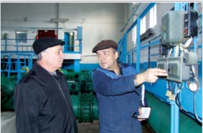
Начальник відділу охорони праці МКП «Хмельницьктеплокомуненерго» О. Іванов (ліворуч) та громадський інспектор з охорони праці Ю. Орлов перевіряють технічний стан обладнання водонасосної станції.
